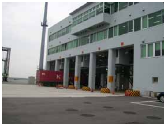
3 管理棟およびOUTゲート
