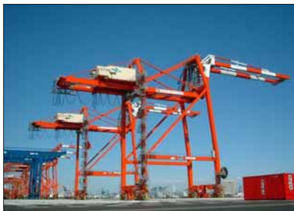
電力回収装置付きクレーン（インバータ制御）
